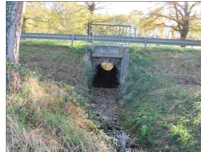
Figure 9 : Le Bellefont au niveau de l'ouvrage passant sous la RD 927
