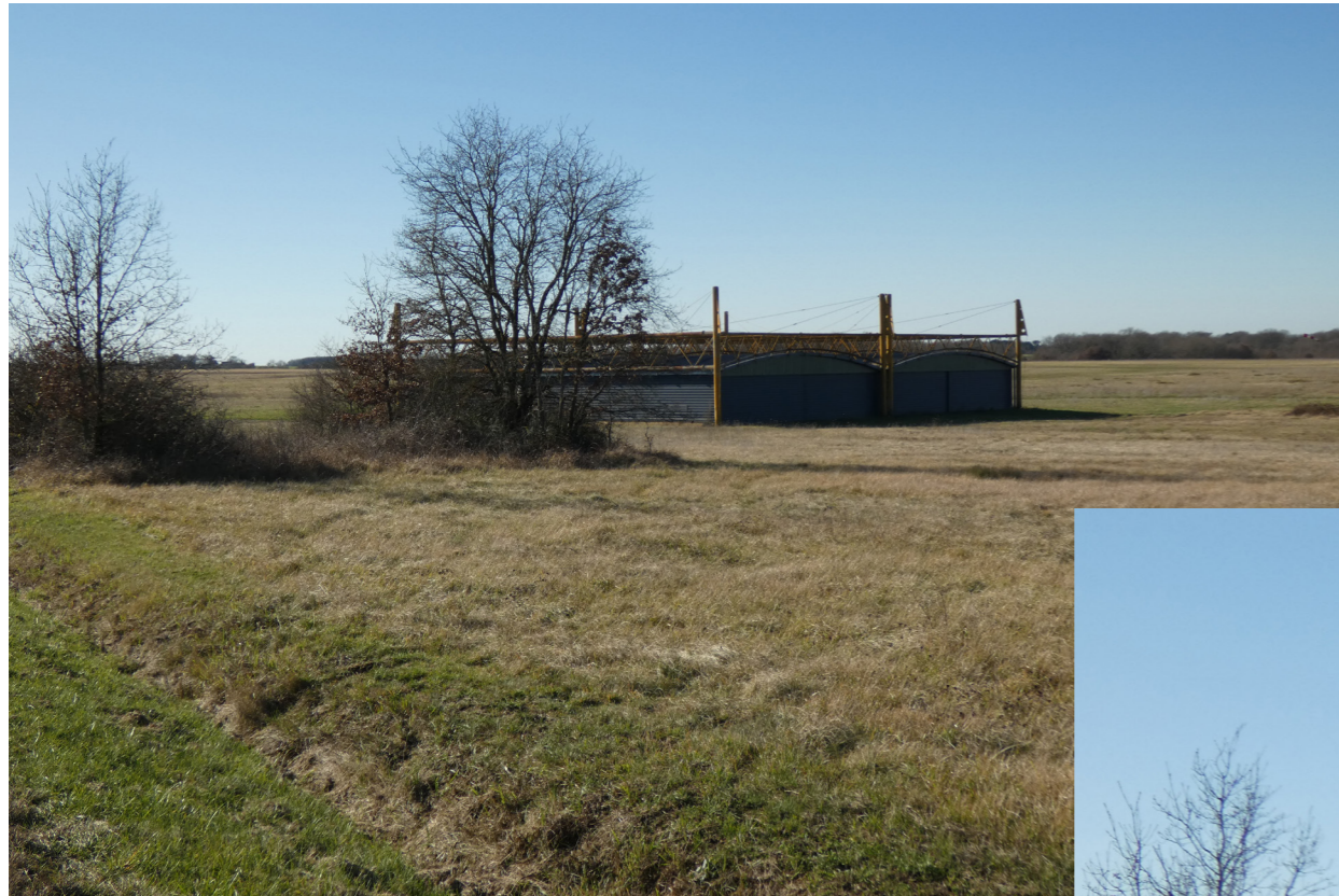
PD 3 - Photographie du hangar à démolir
