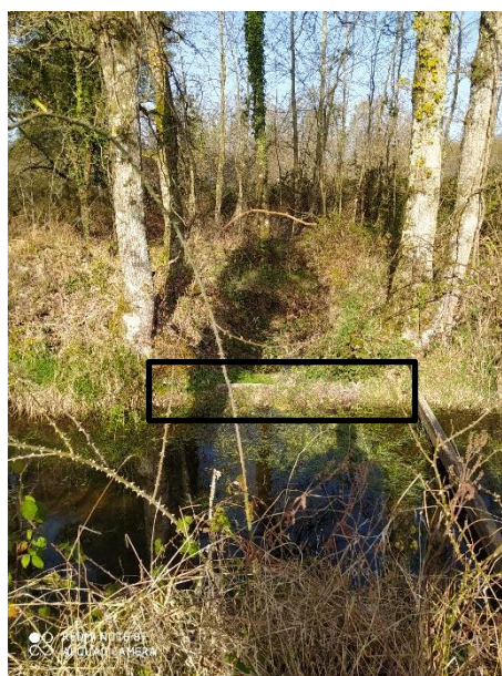
Vue sur le seuil en bois
