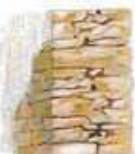
Mur ancien souvent maçonné à la terre, enduit fin à la chaux (intérieur et extérieur)
